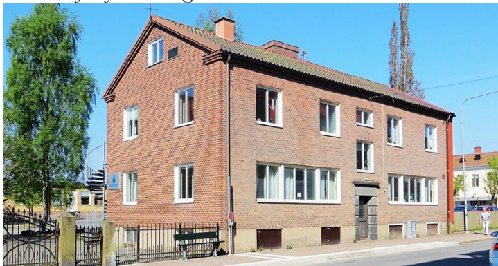
Den tidigare Centralskolans annexbyggnad
