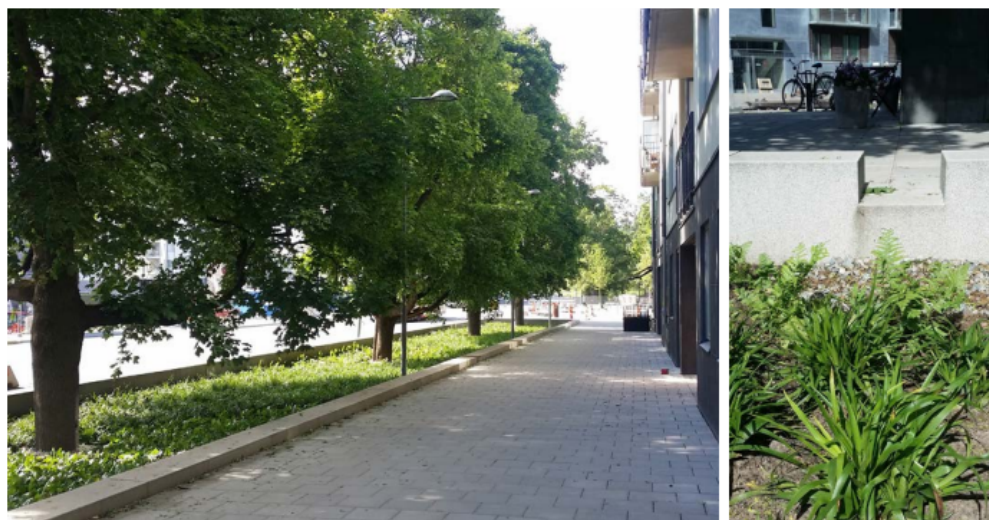
Figur 13. Biofilter i gatumiljö i tättbebyggt flerfamiljsområde, Stockholm. Gestaltning av dagvatten, Sweco
