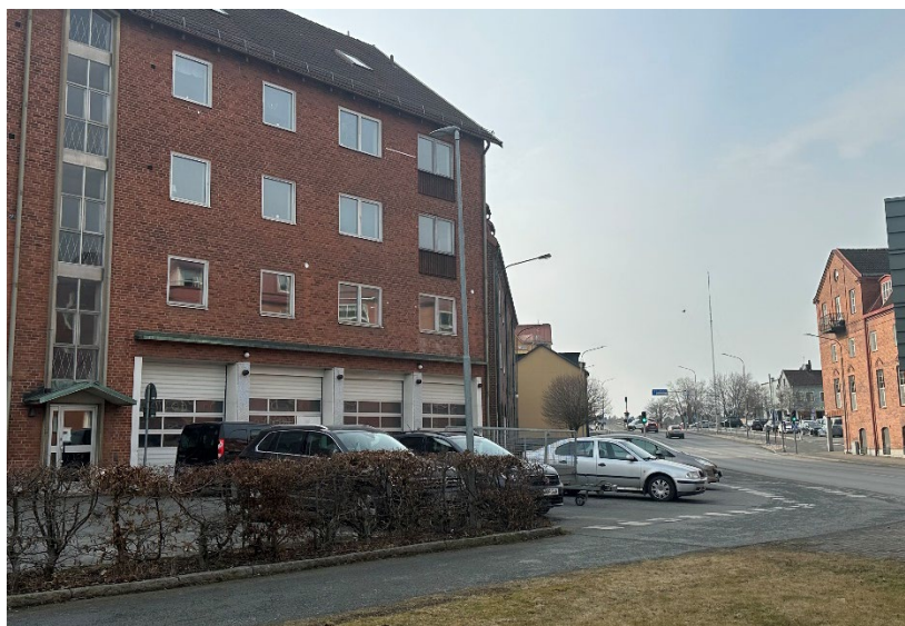
Bilden visar en del av gång- och cykelvägen som går utmed planområdets norra del.
