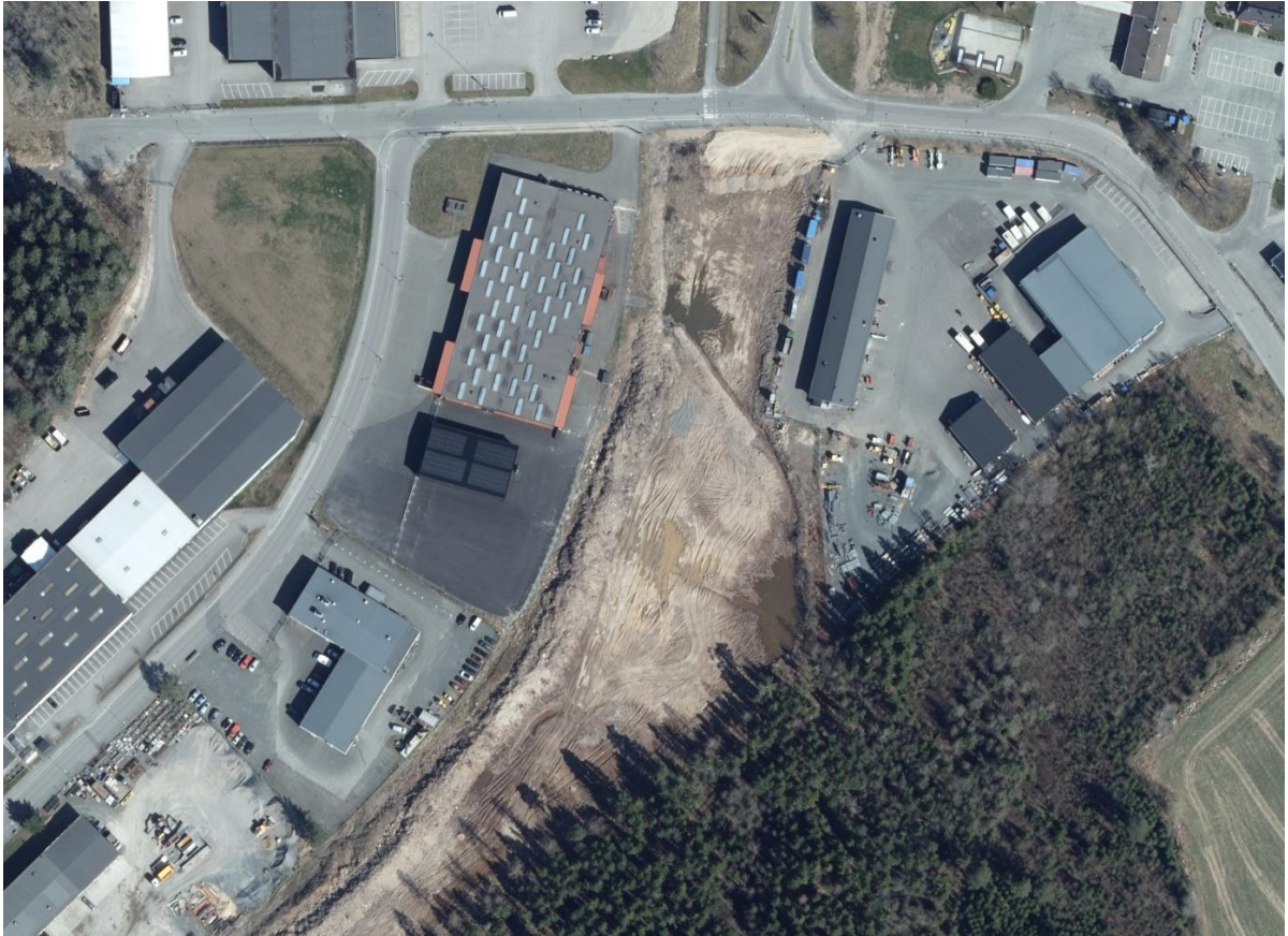
Figur 15. Delsträcka 5 – km 1/950 – 2/180. Flygfoto över vegetationsavtagning och fyllnadsmassor samt blöta partier där vatten ansamlas.
