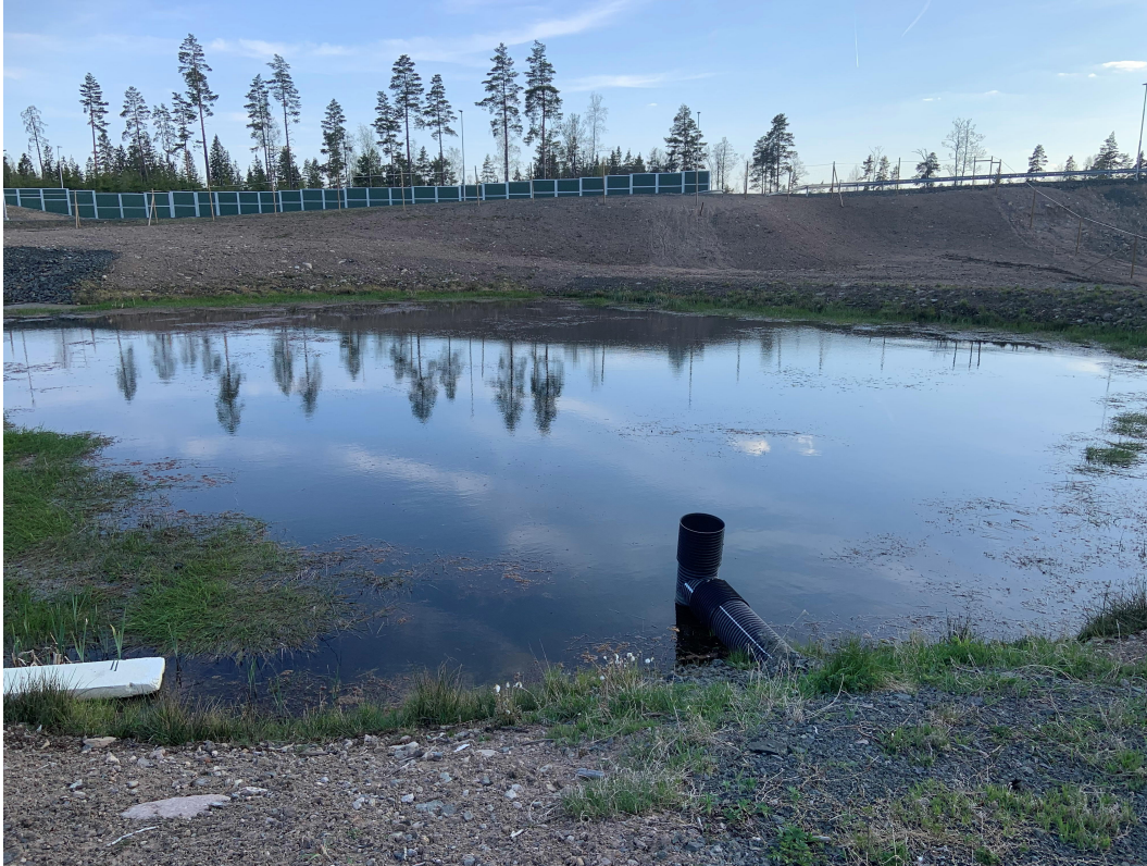
Foto 1. Exempel på en relativt nyanlagd våt damm på första etappen av södra vägen. Utsläppsanordningen syns i förgrunden.
