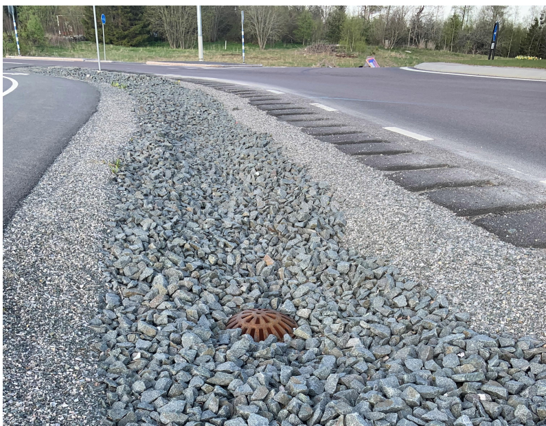
Foto 2. Exempel på befintligt makadamdike. Kupolsilen som avvattnar diket vid översvämning syns i förgrunden.
