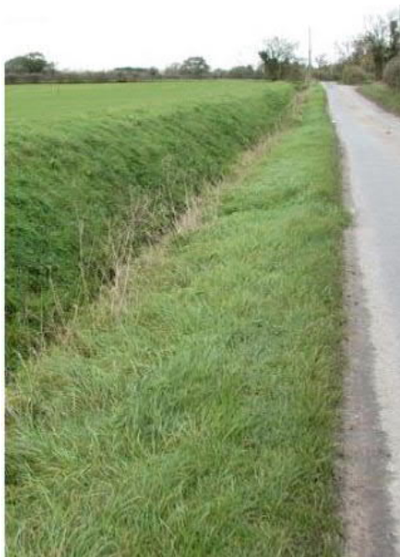
Foto 3. Exempel på befintligt svackdike/gräsdike.
