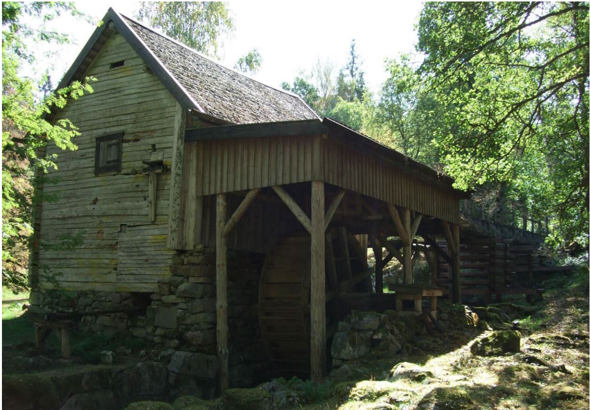
Vy av kvarnen i östlig riktning.
