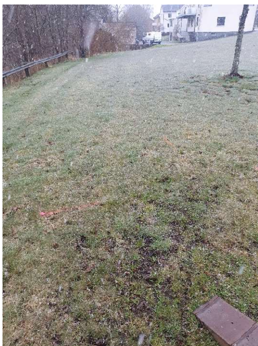
Stödmur med räcke till vänster i bild
