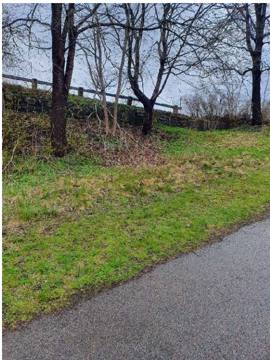
mot sydost Befintlig stenvmur.
