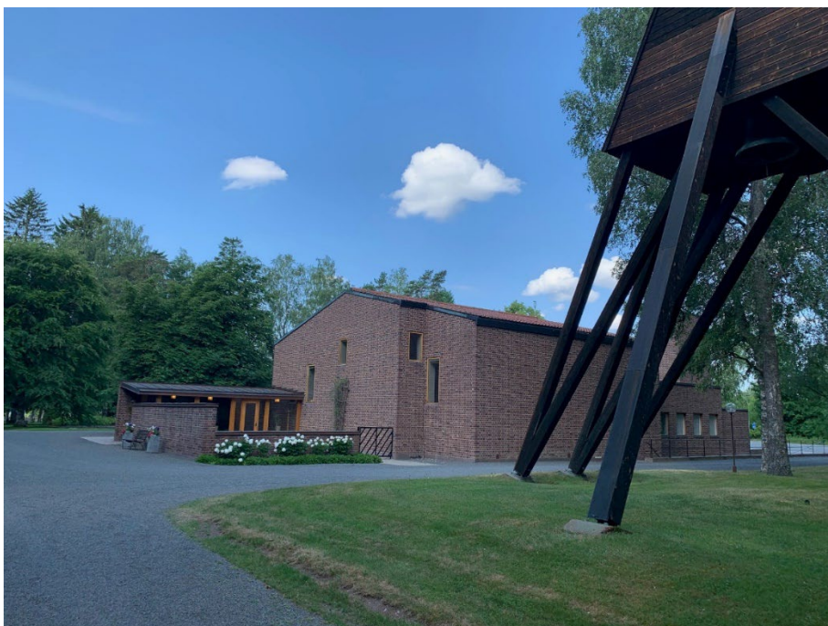
Vy av kapellet med tillhörande krematorium i planområdets norra delar.
