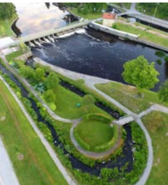
Fiskvandringsväg vid slussen i Svartån, Örebro.
