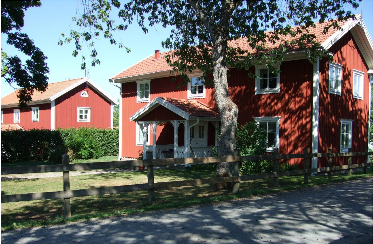
Bostadshus 1:5 närmast i bild och 1:16 bredvid.
