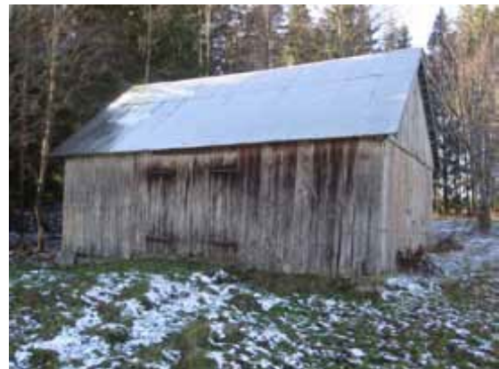
Ängslada i Korpebo med portar på mitten av båda långsidorna
